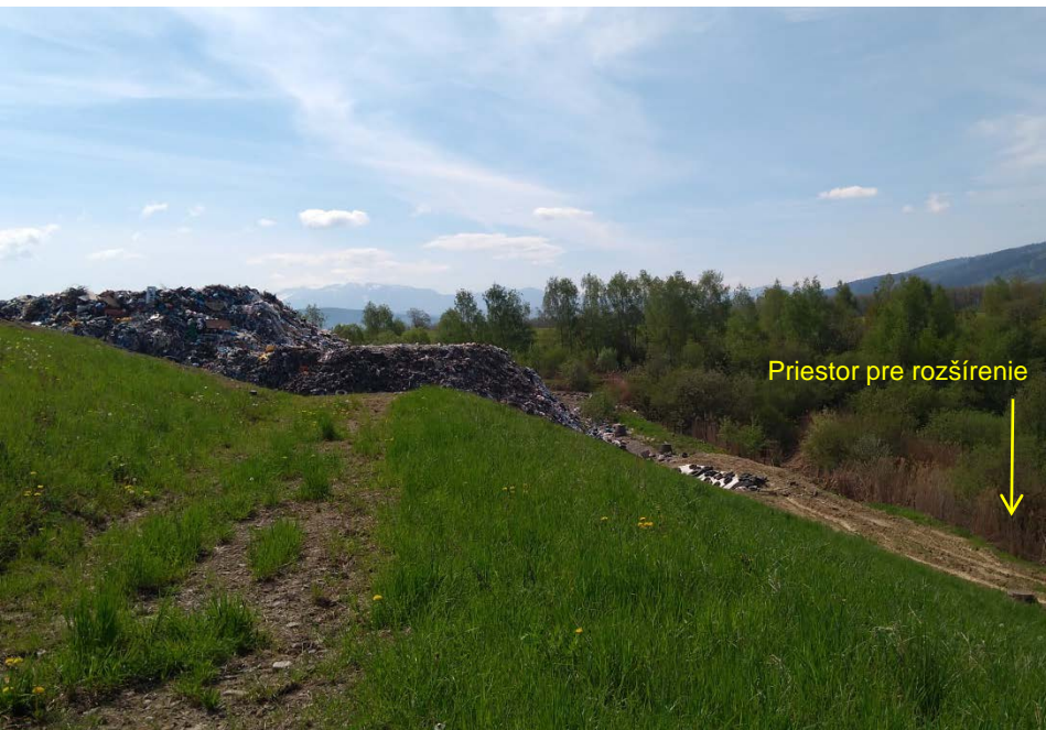
Foto 3 Pohľad na priestor rekultivovanej a funkčnej skládky
